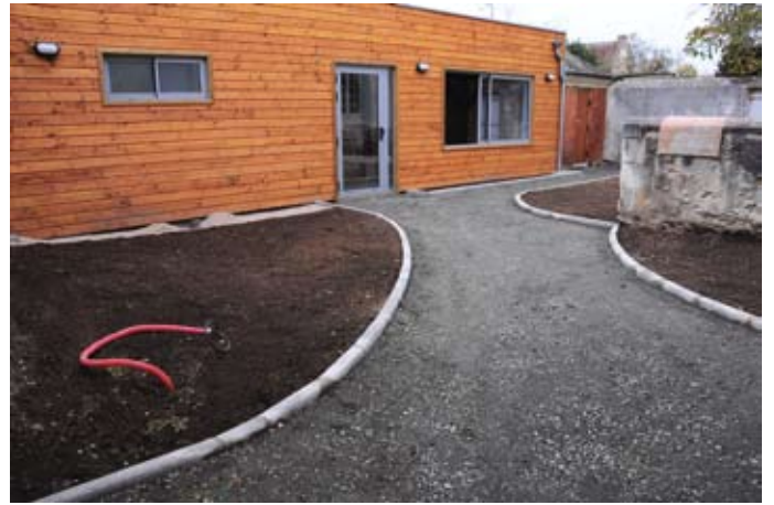
En attente de revêtement
