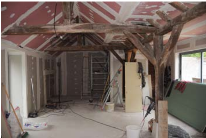
Les poutres ont été conservées
