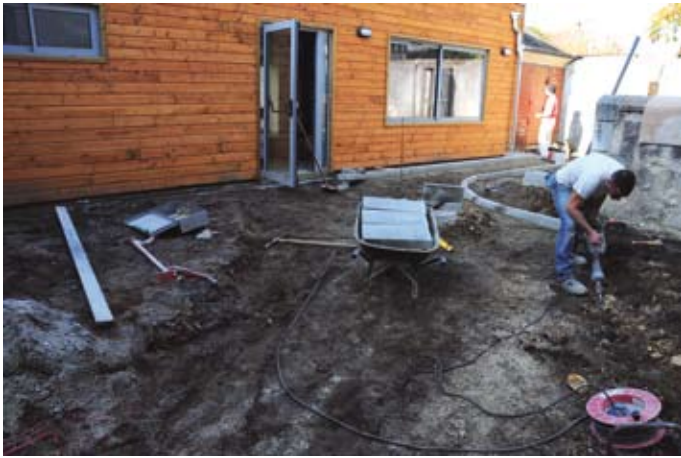
Aménagement de l'extérieur
